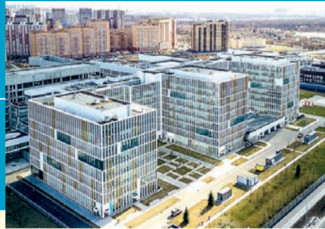
ПОСТАВКИ МЕТАЛЛОПРОКАТА НА СТРОИТЕЛЬСТВО КОРОНАВИРУСНЫХ МЕДЦЕНТРОВ
